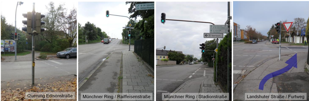
Abb. 30: Fehlendes Fahrradsymbol (Bild links); Signalisierung für den Radverkehr über das Kfz-Signal (2. Bild von links); Doppelte Signalisierung für den Radverkehr: Kfz-Signal und nachfolgendes Fahrradsignal (2. Bild von rechts); Signalisierung gemeinsam mit Fußgängern (Bild rechts)
