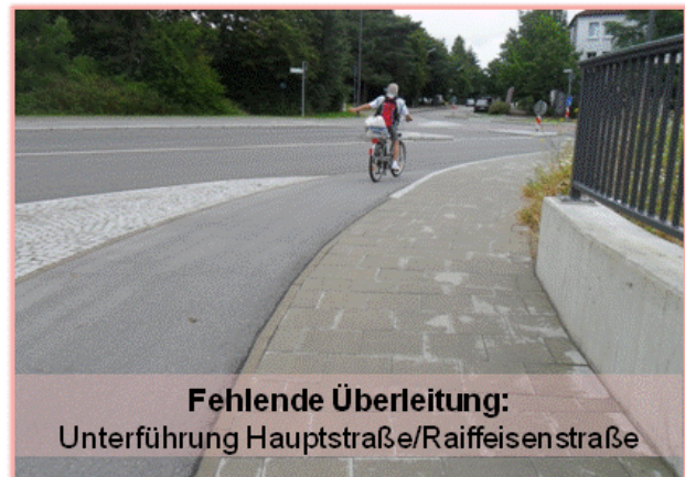
Abb. 20: An der neuen Bahnunterführung sind Überleitungen zum Teil gut gelöst (Bilder oben), zum Teil fehlen Sicherungen (Bild rechts unten). Auch für von RVA abbiegende Radfahrer sind gesicherte Überleitungen sinnvoll (Bild links unten)
