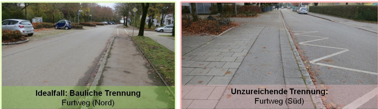
Abb. 18: Bauliche Trennung zwischen RVA und Gehweg (linkes Bild, nicht benutzungspflichtiger Radweg) und weder taktil noch optisch zu erfassende Trennung (rechts Bild)
