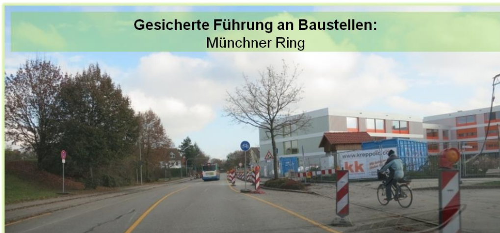
Abb. 25: Gesicherte Überleitung und gesicherte Führung im Baustellenbereich
