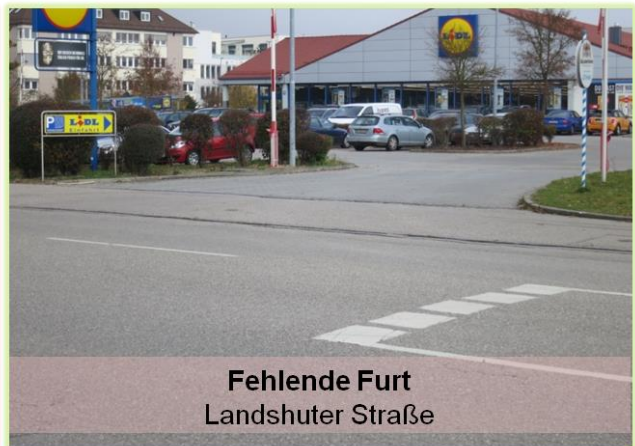
Abb. 19: Fehlende Furtmarkierung bzw. Überleitungsbereich im Bereich des Radwegeendes (Bild oben links), gut sichtbare Furtmarkierung (Bild oben rechts), erkennbare Furtmarkierung aber ohne Hinweis auf die besondere Gefährdung linksfahrender Radfahrer (Bild unten links) und fehlende Markierung im Bereich einer stark frequentierten Zufahrt (Bild unten rechts).
