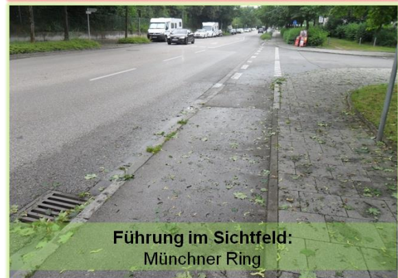
Abb. 21: Gute Sichtbeziehungen, aber eine weit abgesetzte Führung des Radverkehrs birgt Konfliktpotential (Bild links oben); Randbewuchs vermindert die Sicht auf die nachfolgende Führung, Hindernisse und auf Fußgängern (Bild oben rechts); Eine abgesetzte Führung im Seitenraum verhindert den Blickkontakt in Knoten (Bild unten links); Eine Führung unmittelbar an der Fahrbahn sorgt für gute Sichtbeziehungen (Bild unten rechts).
